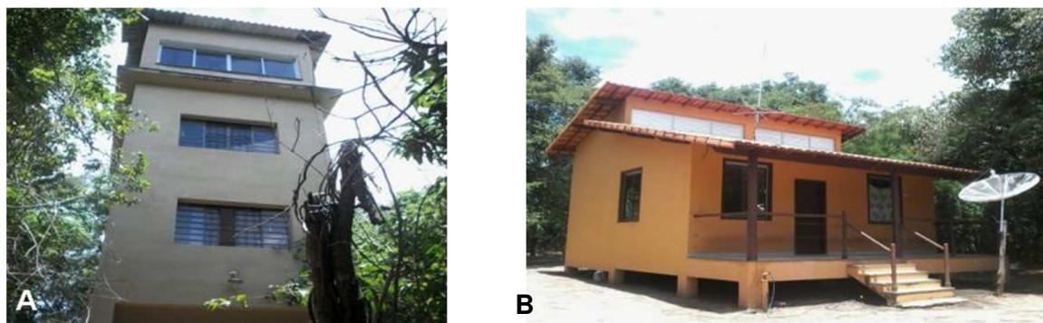
Figura 51. Estrutura de apoio às operações de combate a incêndios no REVSRP, localizado no interior da APAE do Rio Pandeiros. A - Torre de Observação e alojamento e; B - Alojamento próximo ao Pântano.
