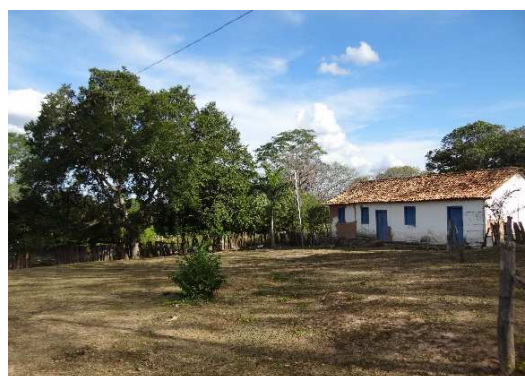
Edificação centenária, Fazenda Santa Maria
