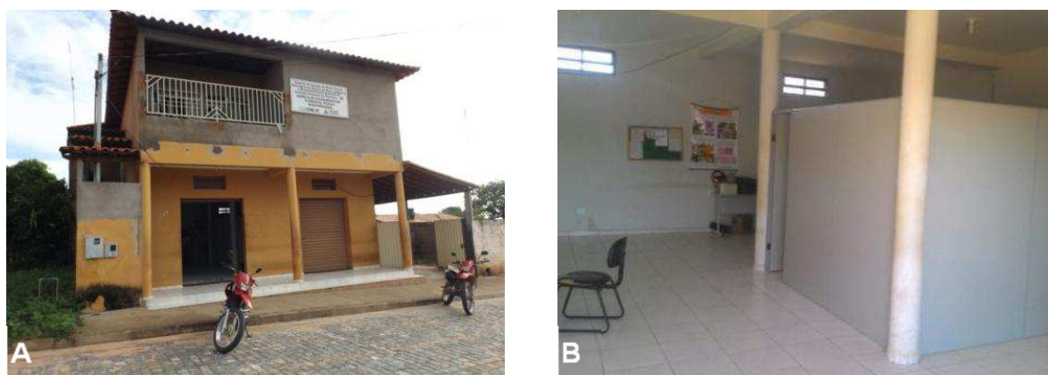
Figura 47. Sede administrativa da APAE do Rio Pandeiros, Bonito de Minas, MG. A - Fachada da sede administrativa e; B - Área interna da sede administrativa. Fotos: Altenfelder Fonseca.
